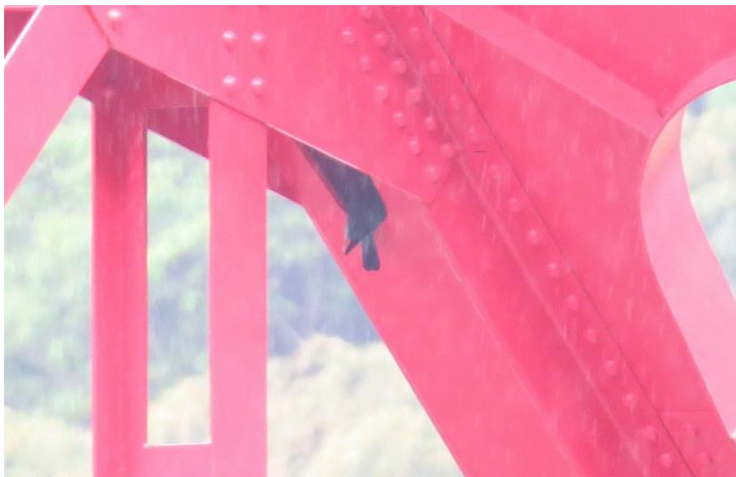
▲西園橋のハンドホールに入るブッポウソウ・矢部村日向神ダム 撮影：KT
